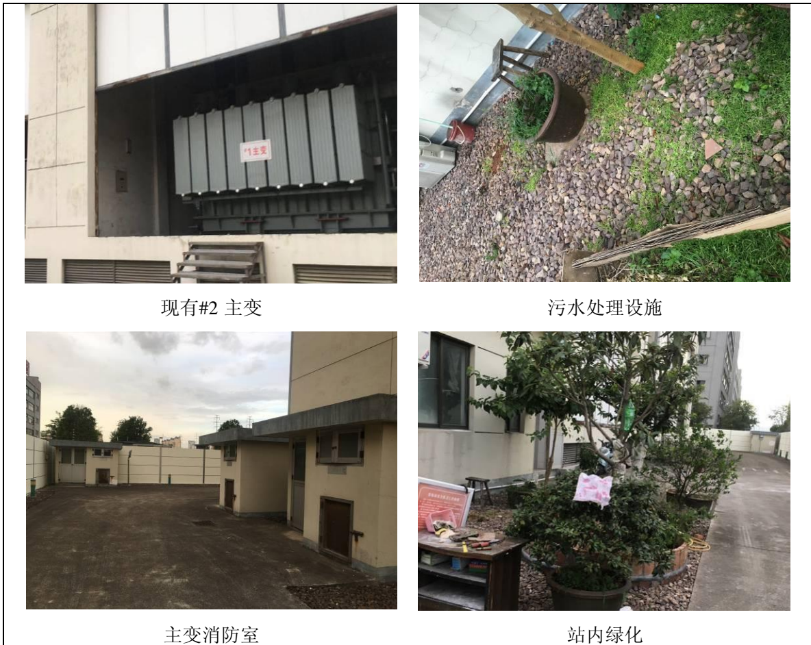
图 3-8 110kV 开诚变电站现状
