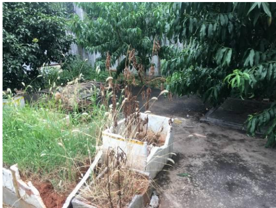
污水处理设施
