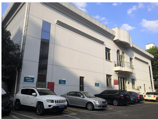
110kV 城中变电站主控楼
