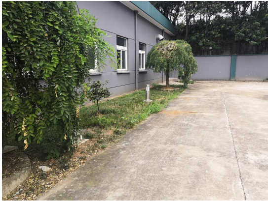
110kV 罗店变电站主控楼
