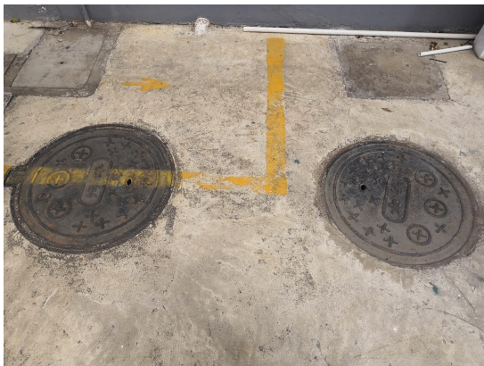
110kV 罗店变电站污水处理设施
