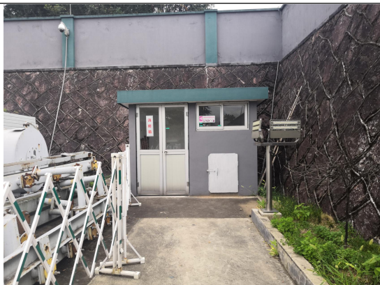
110kV 罗店变电站主变消防室
