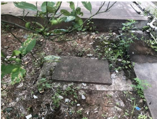
污水处理设施
