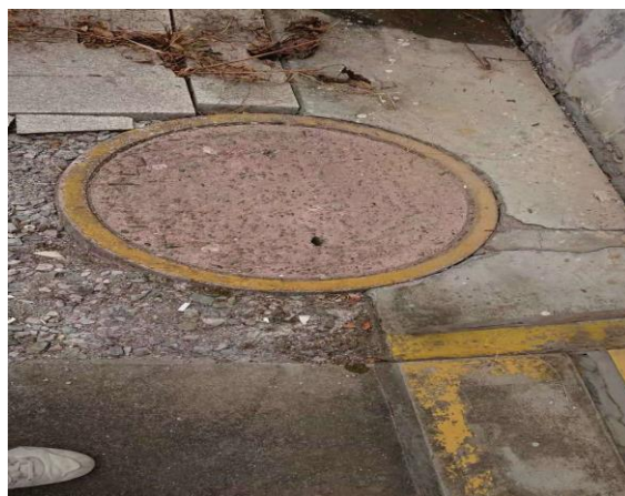
110kV 东皋变电站污水处理设施
