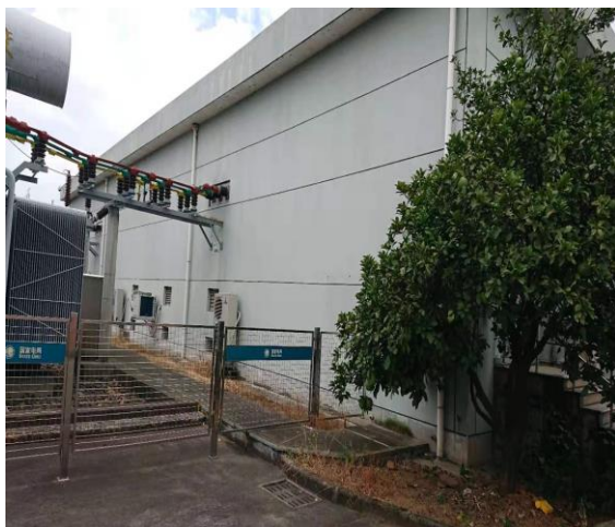
110kV 东皋变电站主控楼
