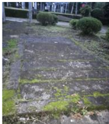
220kV 方岩变电站事故油池
