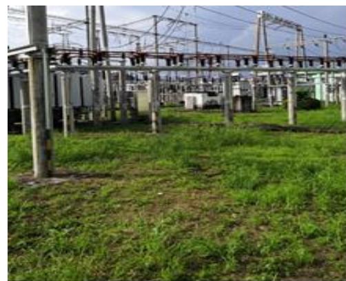
220kV 方岩变电站站内绿化
