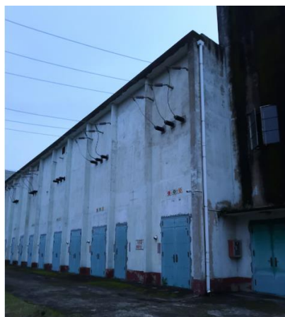
220kV 方岩变电站主控楼
