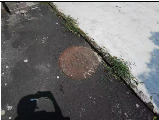
220kV 方岩变电站污水处理设施
