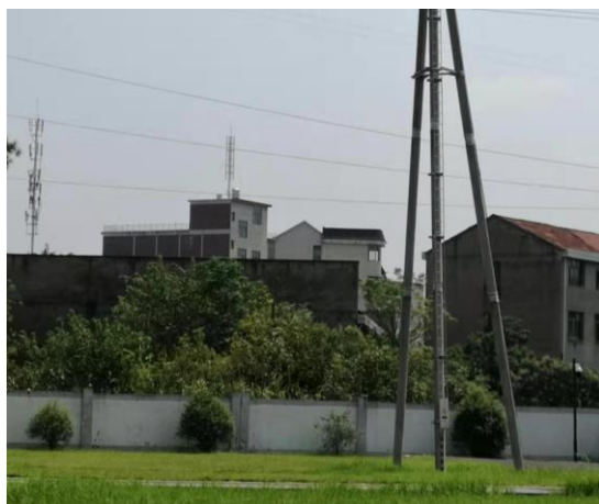
110kV 武义变电站站内绿化
