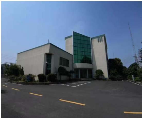
110kV 武义变电站主控楼
