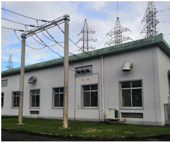
110kV 洋头变电站主控楼
