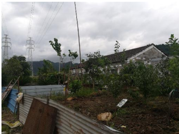
下余村西首民居 清洋线南侧 5m
