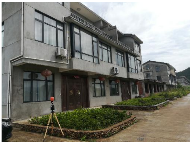
寺前村东首民居 清洋线北侧 26m
