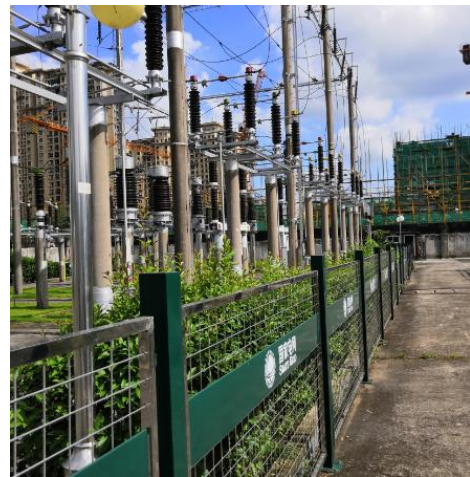
110kV 洋头变电站站内绿化及地面硬化
