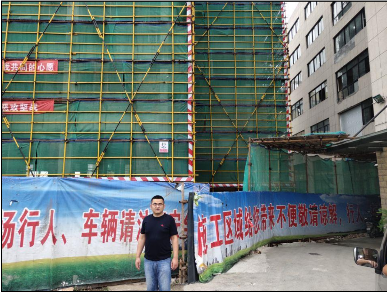
附图 6 现场踏勘照片
