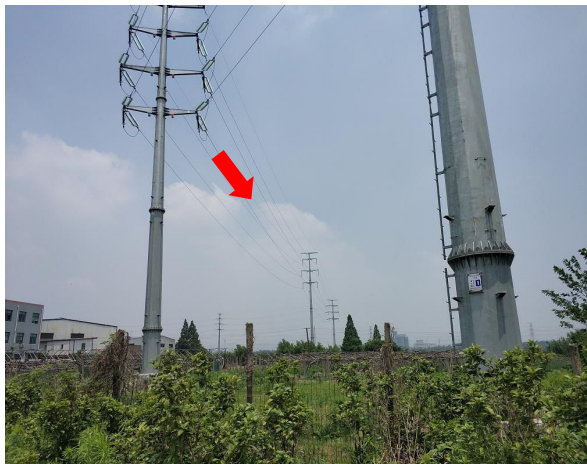
图 6-15 架空线路周边环境状况
