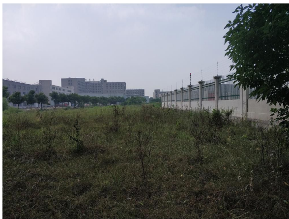
图 6-11 变电站周边环境现状
