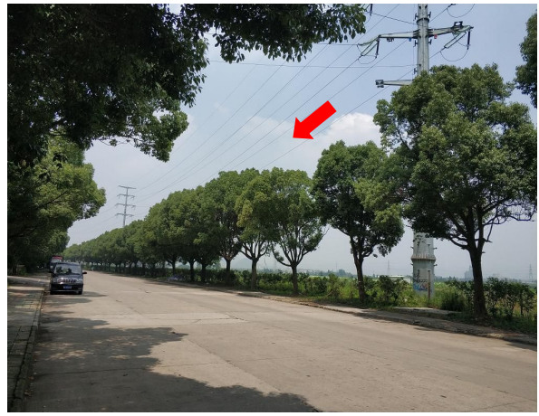
图 6-14 架空线路周边环境状况
