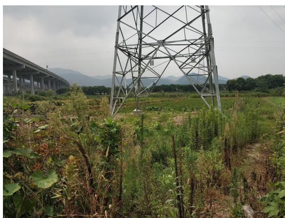
图 6-12 塔基周边环境现状
