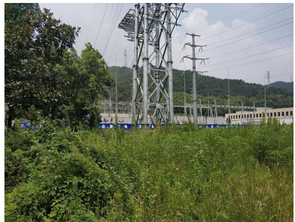
图 6-16 塔基周边环境现状
