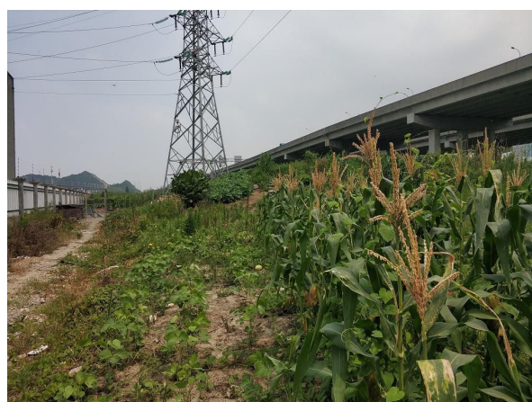
图 6-11 变电站周边环境现状
