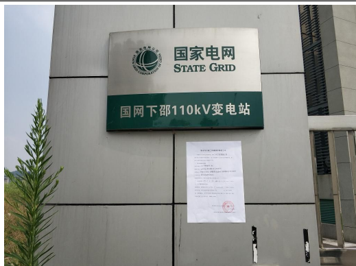
图 8-1 张贴在变电站门口的公示
