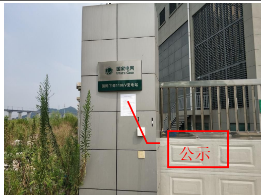
图 8-2 张贴在变电站门口的公示
