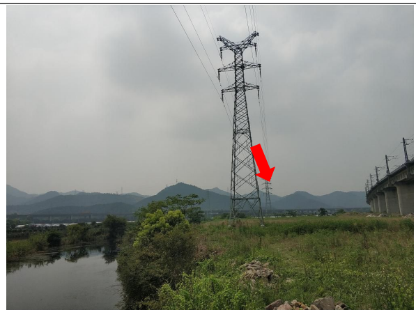
图 6-14 架空线路周边环境状况
