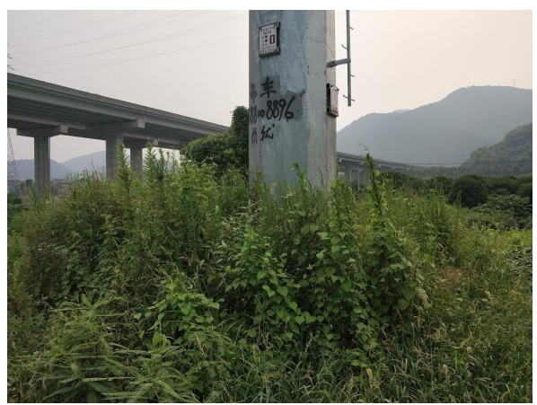
图 6-12 塔基周边环境现状
