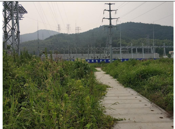
图 6-16 电缆线路周边环境状况
