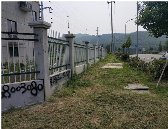
图 6-11 变电站周边环境现状
