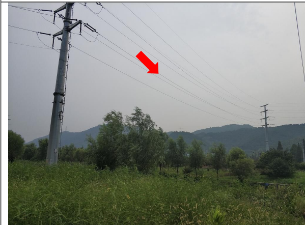
图 6-15 架空线路周边环境状况
