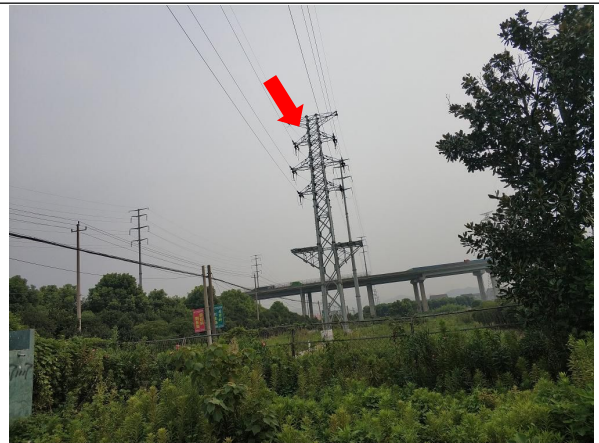
图 6-14 架空线路周边环境状况
