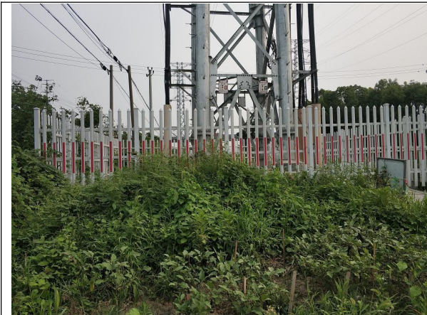
图 6-13 电缆终端塔基周边环境状况
