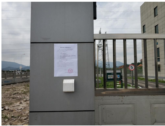
图 8-1 张贴在变电站门口的公示
