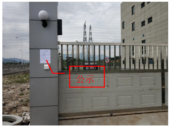
图 8-2 张贴在变电站门口的公示
