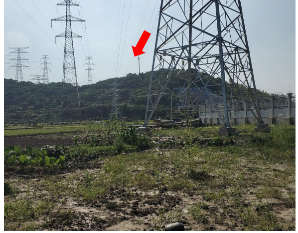
图 6-14 架空线路周边环境状况
