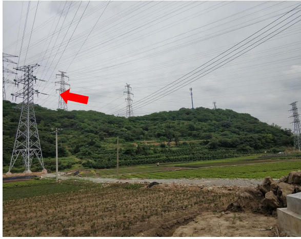
图 6-13 架空线路周边环境状况
