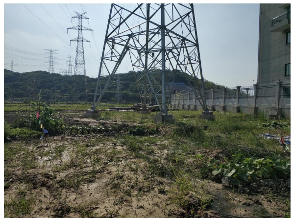
图 6-12 塔基周边环境现状
