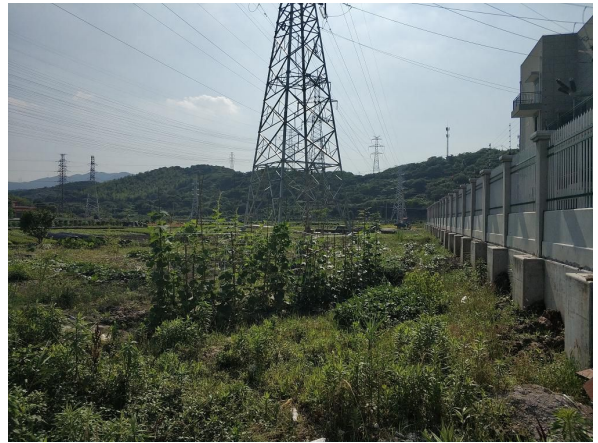
图 6-10 变电站周边环境现状
