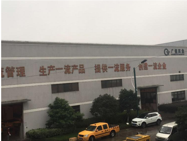
东侧隔厂区道路为杭州广银电力设备实业有限公司厂房
