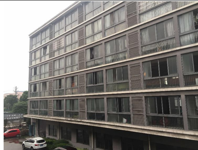
北侧隔厂区道路为闲置厂房
