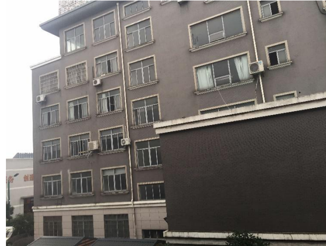
南侧隔墙为杭州广银电力设备实业有限公司办公楼
