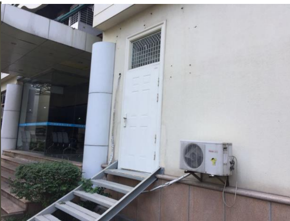
ECT 机房北侧
