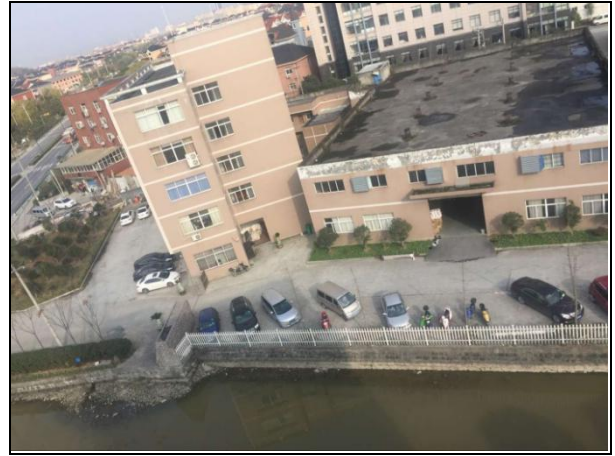
项目北侧小河及河对面厂房
